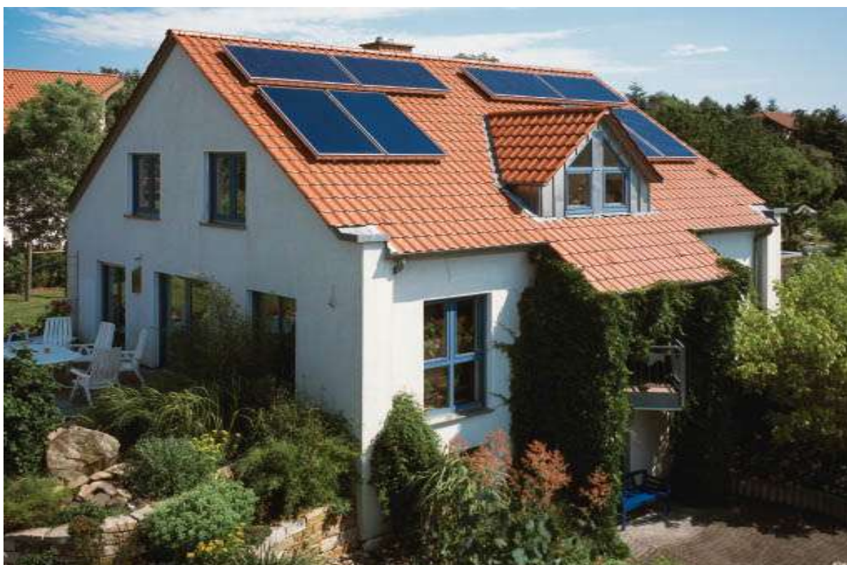
Rys. 2.6. System kolektorów słonecznych na dachu domu jednorodzinnego © Czas Białegostoku
