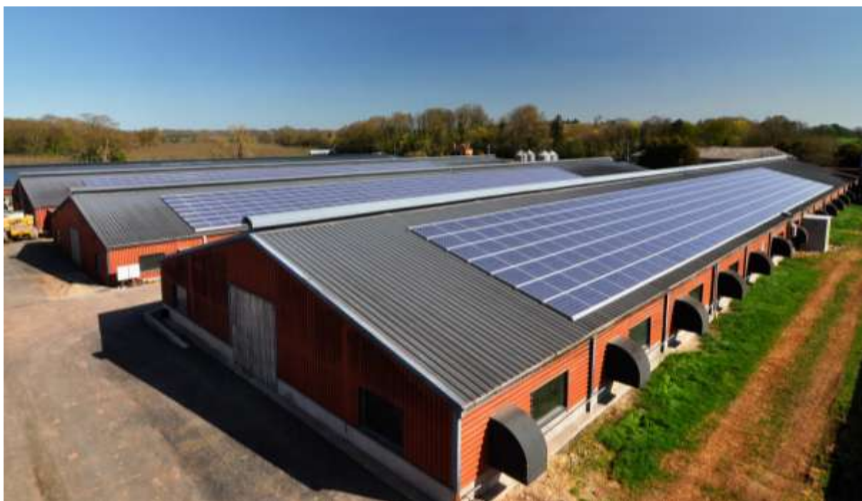
Rys. 2.1. Instalacja fotowoltaiczna na dachu chlewni © Ben Whitle, flickr.com
