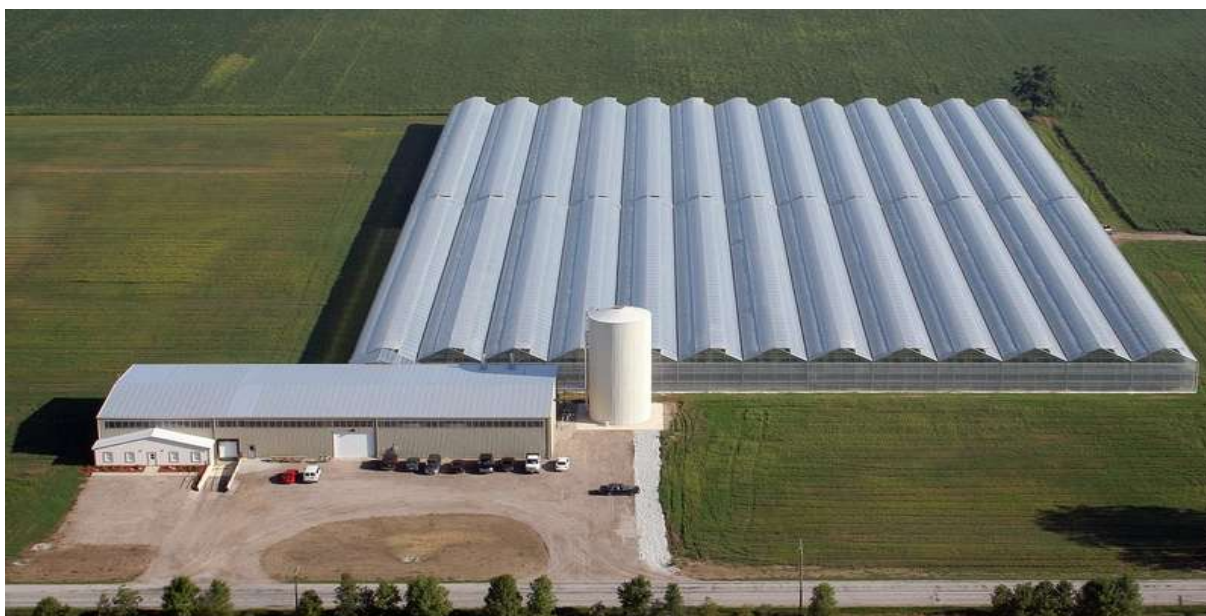
Rys. 2.7. Kotłownia na biomasę do ogrzewania upraw szklarniowych © Blue Flame Stoker
